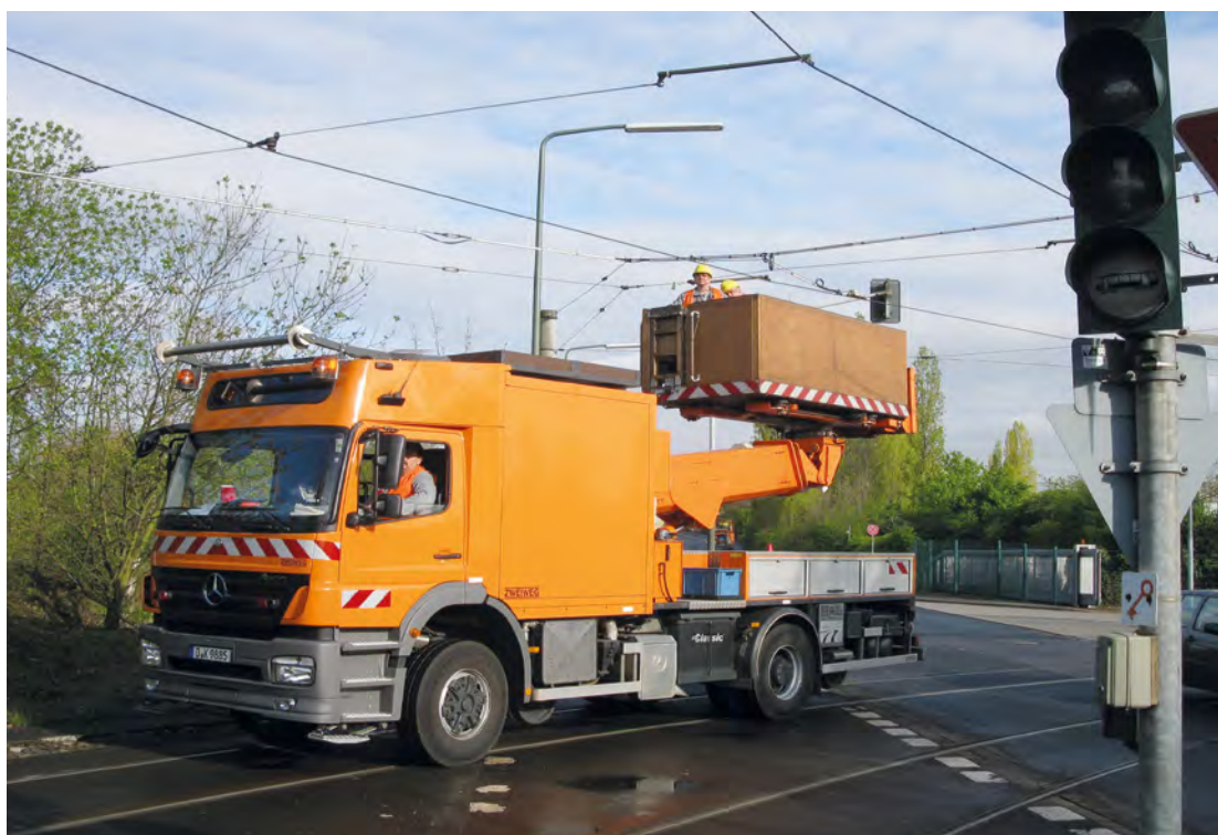
Abbildung 1: Das Zusammentreffen mehrerer Gefährdungen wie elektrische Spannung, Arbeitshöhe, Bahnverkehr und Individualverkehr erfordert besondere Arbeitsverfahren und eine hohe fachliche Qualifikation.
